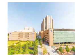
帝京大学医学部附属病院 (東京都板橋区)
